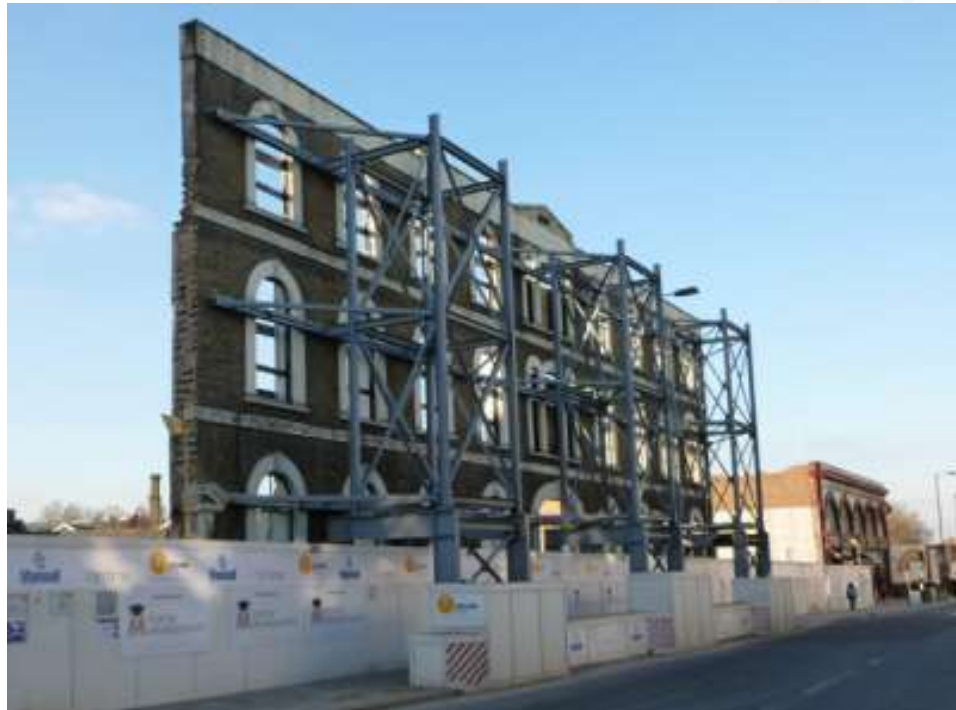
Primjer zadržavanja jednog fasadnog pročelja
