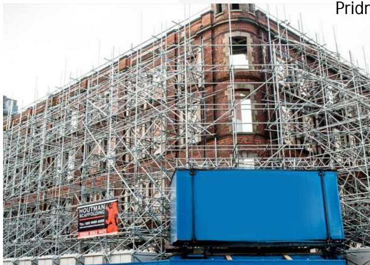
Pridrzanje cijevnim skelama
